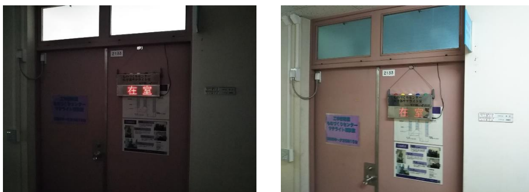
図 3 取り付けした LED 表示器の点灯
