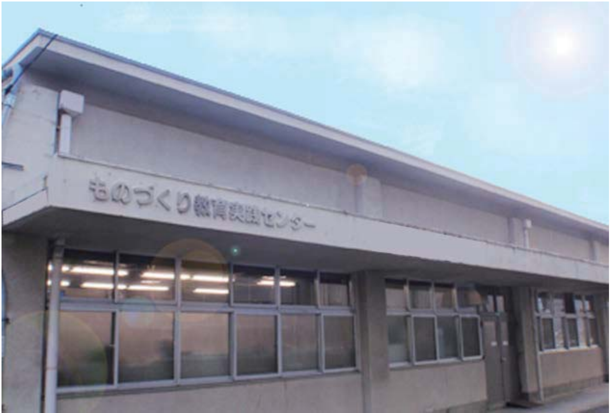
製造システム技術室外観
