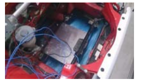
4. バッテリーを取り付けるための台の作成
